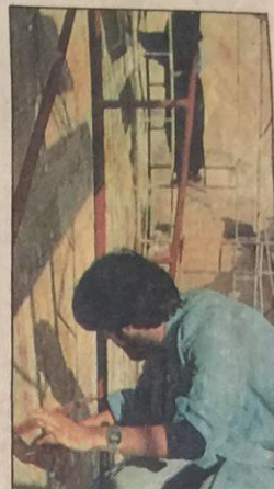
Calle abajo, mural arriba, en la intersección de Guimera y Rudolph una enorme muralla se cubre con un no menos enorme mural. El andamio es alto y el suelo está muy abajo.
